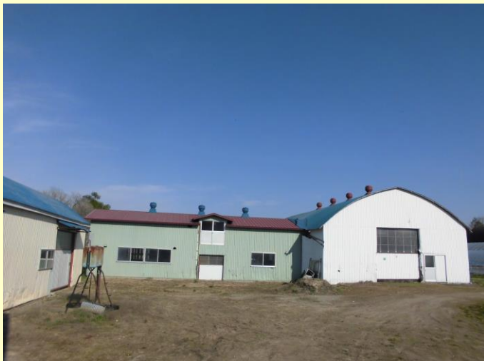
住宅に隣接する倉庫（3棟）
